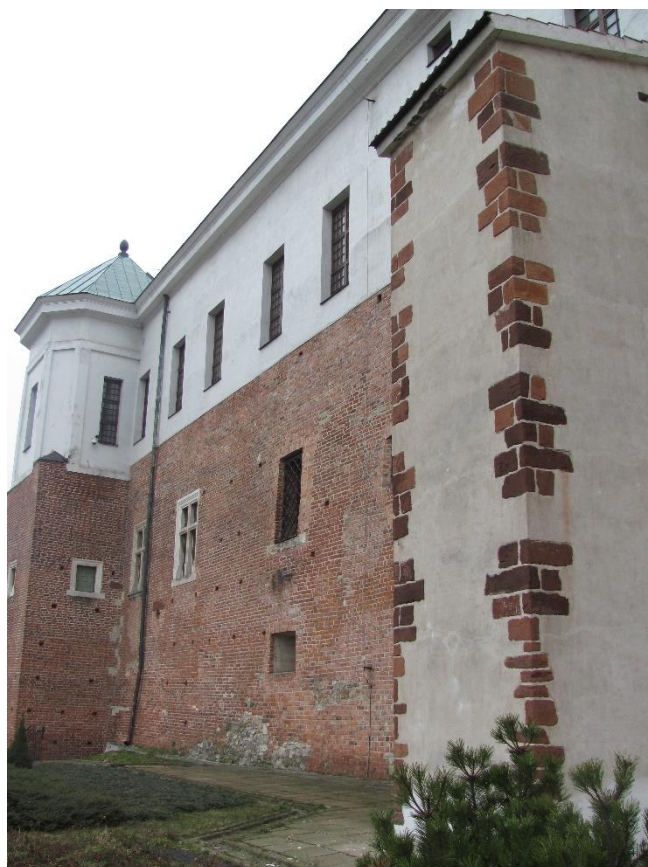
Zdj. 2 Elewacja zachodnia
