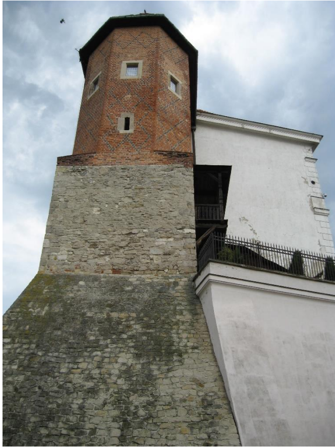
Zdj. 3 Baszta południowa, schody drewniane.
