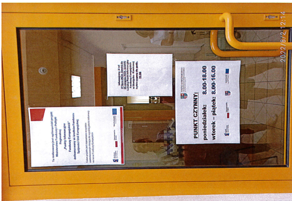
Fot. nr 20 Drzwi wejściowe – LPI w Skarżysku - Kamiennej
