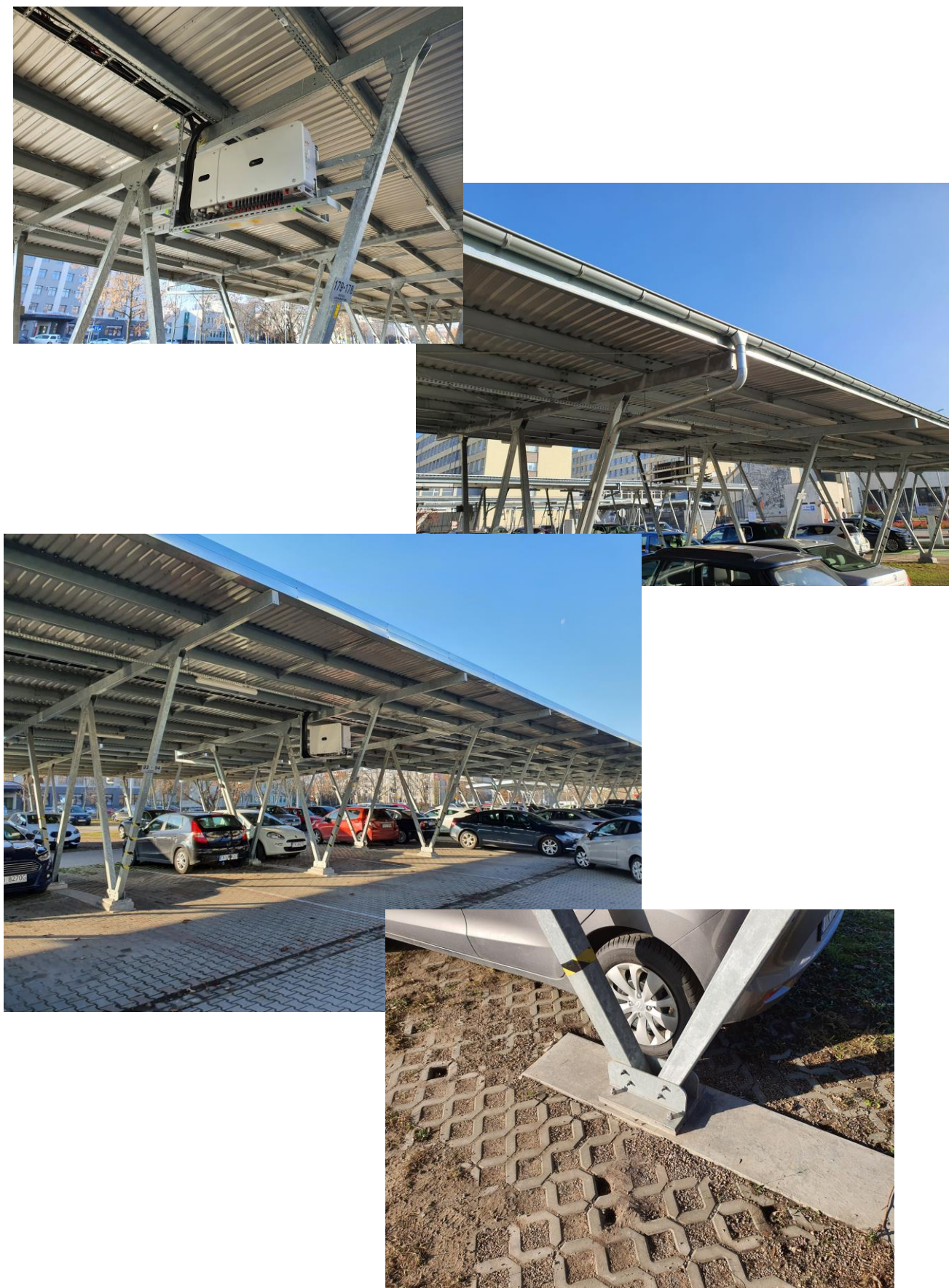
Rys. 1. Wzorcowa konstrukcja wiaty pod instalację fotowoltaiczną.
