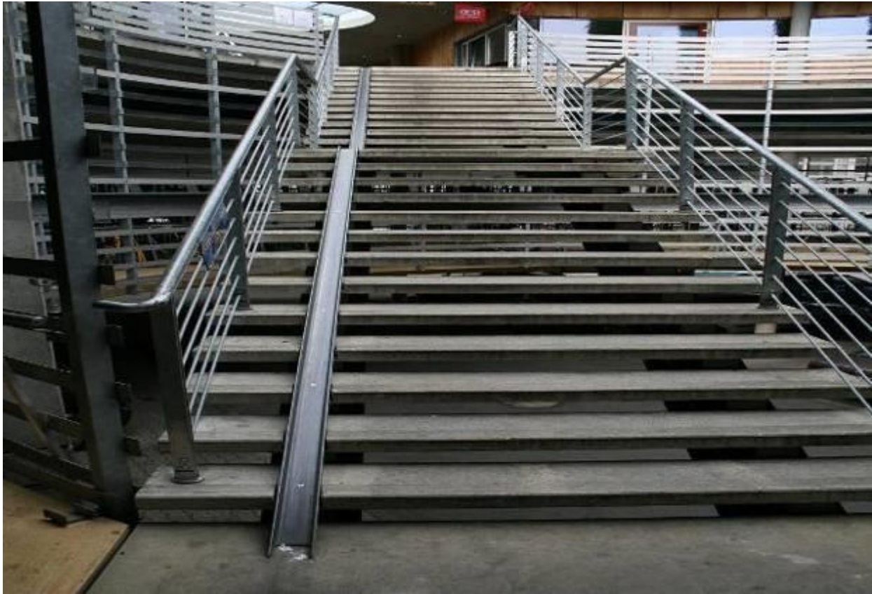
Ilustracja 15: Rampa dla rowerów na schodach.
