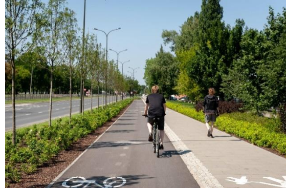
Rysunek 25. Warszawa. Prawidłowa nawierzchnia drogi dla rowerów oraz jej położenie względem chodnika, separacja od ruchu pieszego oraz zieleń (drzewa) zwiększająca atrakcyjność
