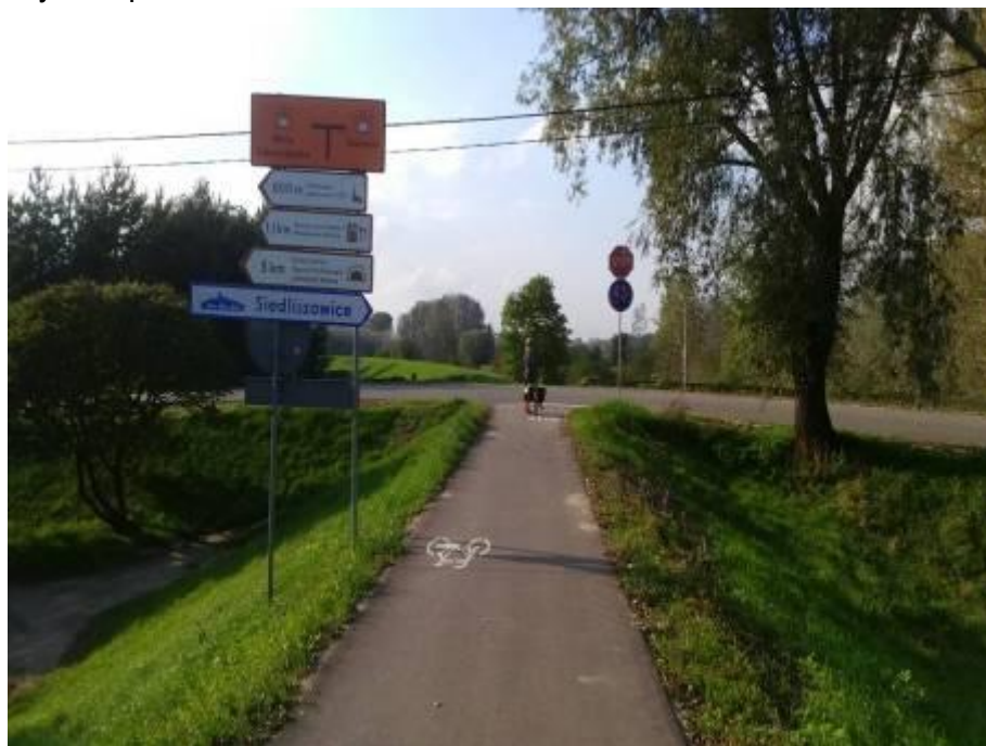
Ilustracja 23: Przykład oznakowania trasy rowerowej przed skrzyżowaniem
