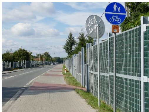
Rysunek 8. CPR wzdłuż DW Sielpia – Końskie nawierzchnia z kostki brukowej i brak zachowania niwelety na wyjazdach z posesji
