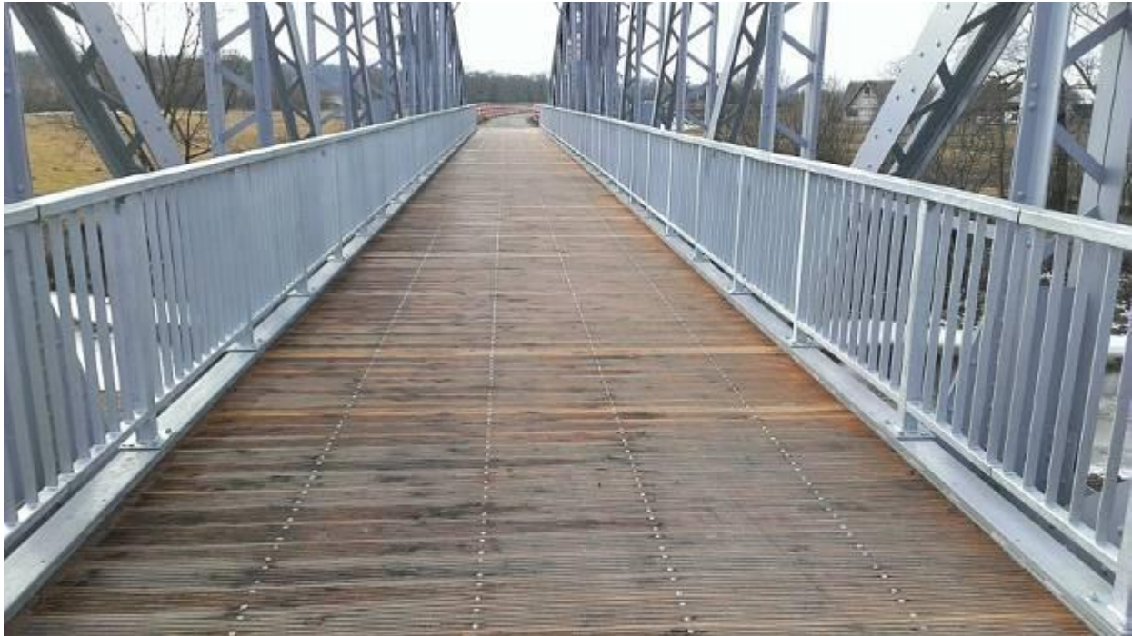
Ilustracja 20: Przykład adaptacji mostu kolejowego na kładkę rowerową (okolice Ludźmierza, powiat nowotarski).
