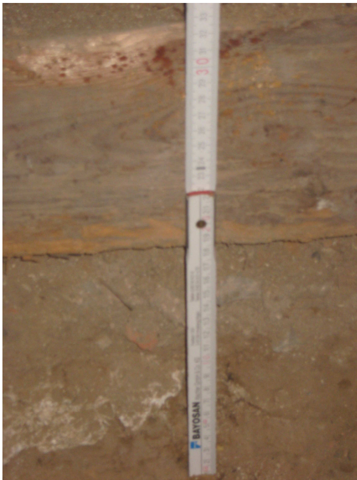
Zdjęcie odkrywki - legar pod podłogą w sieni (2010 r )
