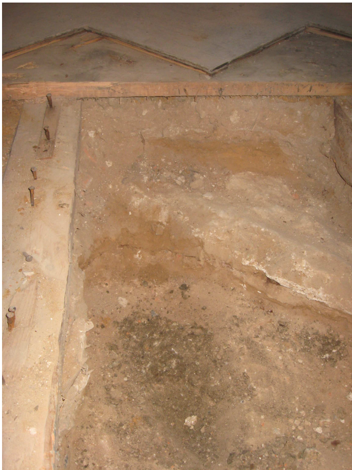
Zdjęcie odkrywki nr1 - podłoga w sieni (2010r )
