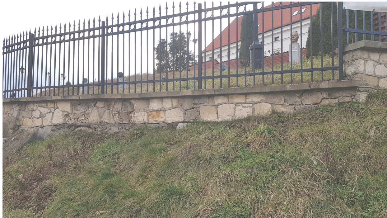
fot. Nr 2 Fragment muru kamiennego z piaskowca w górnej części ul. Zamkowej- stan zachowania okładziny
