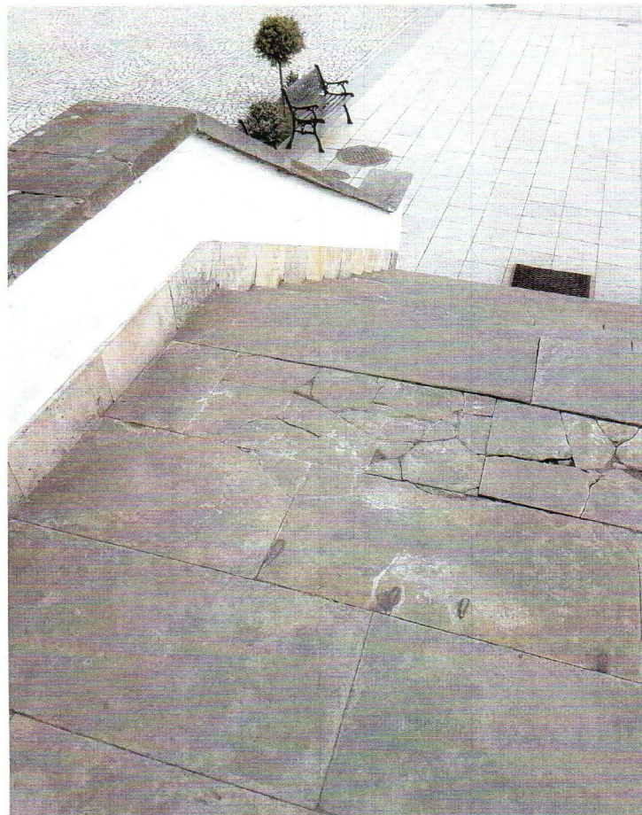
fot. Nr 2 Widok spocznika z zejściem do biegu wejścia głównego – stan zachowania okładziny
