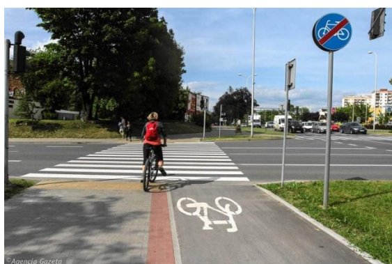
Rys. nr .... Kielce, ul. Źródłowa - brak przejazdu dla rowerów
