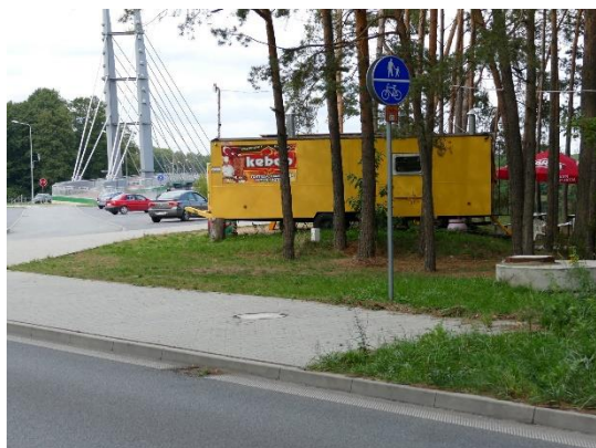
Rys. nr. ... Wysoki krawężnik, Sielpia, brak możliwości wjazdu na CPR
