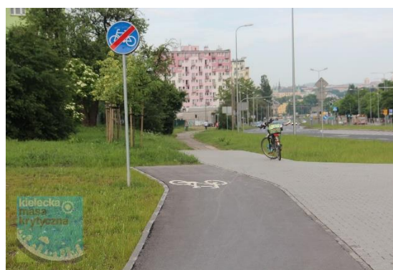
Rys. nr .... Kielce, ul. Grunwaldzka - brak możliwości wjazdu i zjazdu z drogi dla rowerów
