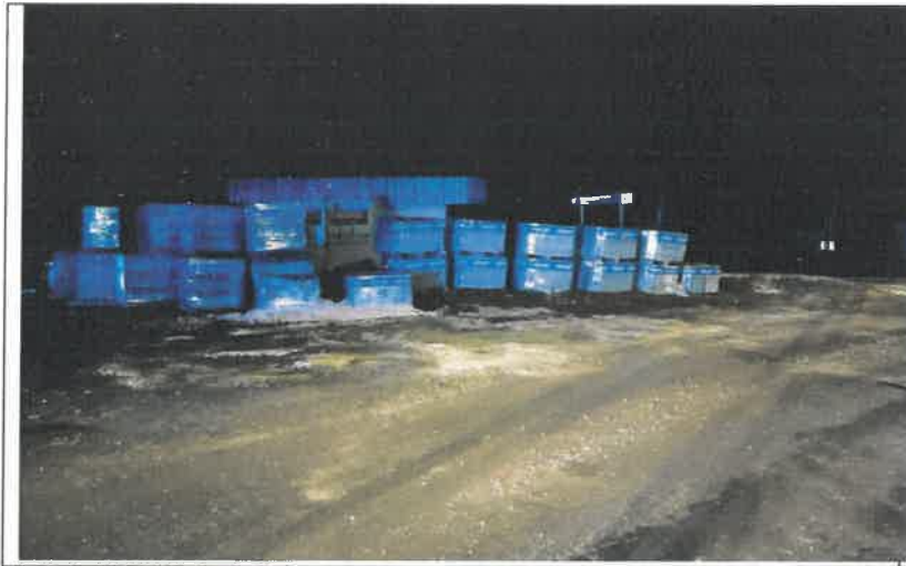
Fot. Nr 5. DW 748. Składowanie materiałów budowlanych w obrębie skrzyżowania, ograniczających widoczność
