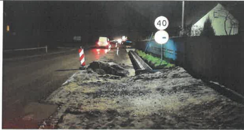
Fot. nr 2. DW 748. Niewłaściwa odległość posadowienia znaków od krawędzi jezdni drogi wojewódzkiej – stwierdzona w terenie 4,8m
