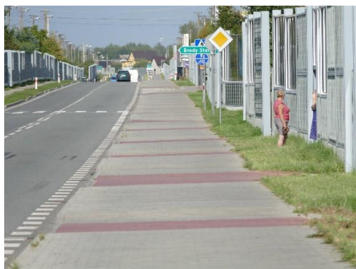
Rys. nr .. Sielcia - Końskie - brak zachowania niwelety na wyjazdach z posesji, tzw. „fale Dunaju”.
