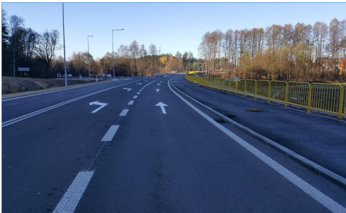
Opis: DW 762 na odcinku węzeł Kielce Południe (S7) – granica gminy Chęciny , Źródło: ŚZDW w Kielcach
