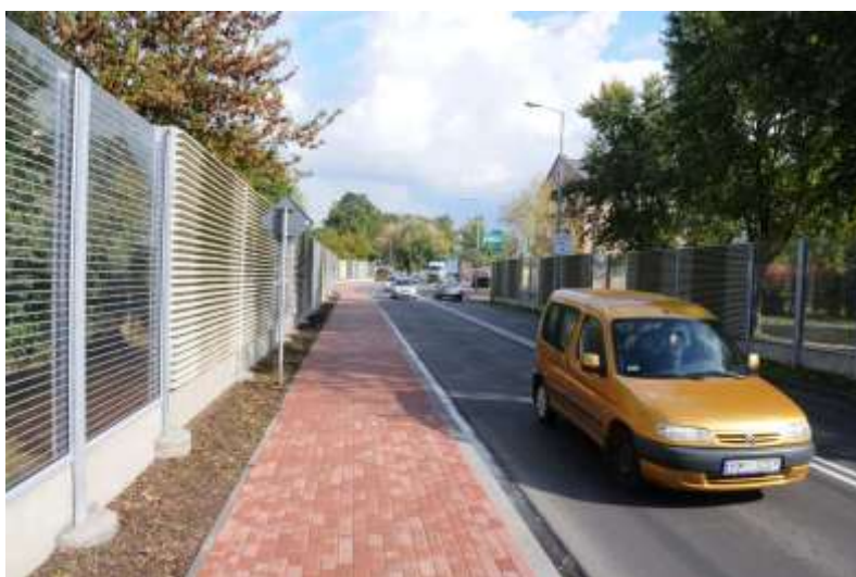
Rysunek 53. Ekran akustyczny z elementami przezroczystymi
