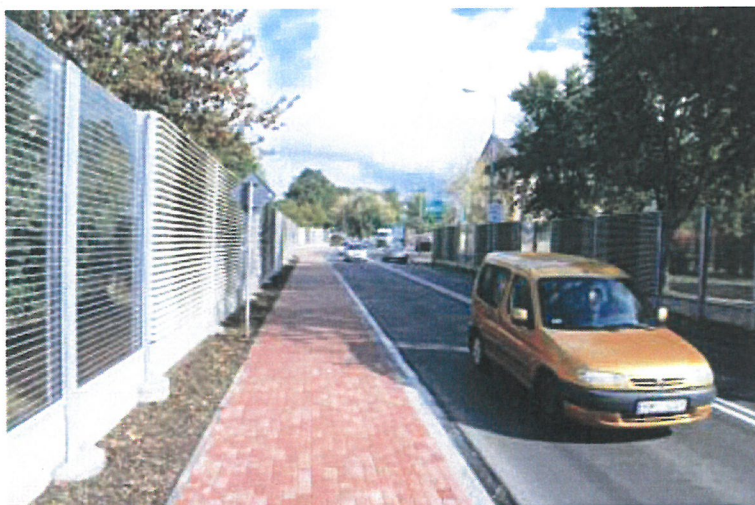
Rysunek 53. Ekran akustyczny z elementami przezroczystymi
