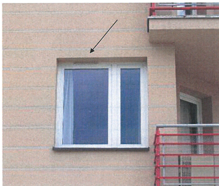
Rysunek 54. Okno dźwiękoszczelne z nawietrzakiem.
