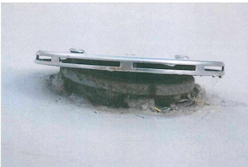
Fot. 6 Niestarannie osadzony element doprowadzający wodę
