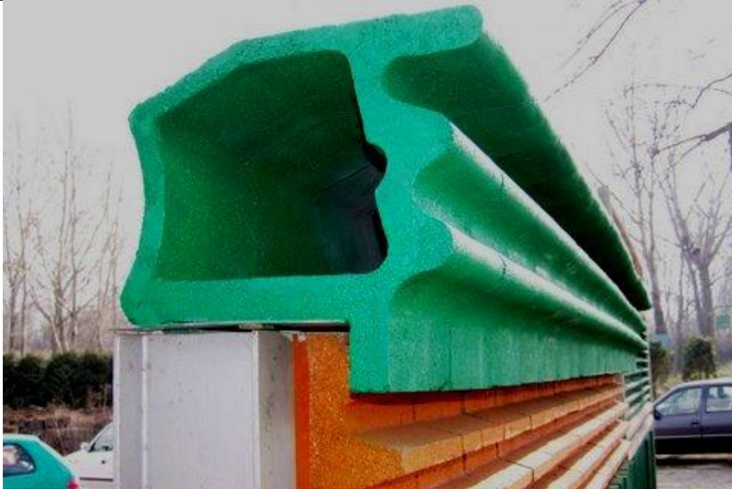
Rysunek 12-8 Dyfraktor zamontowany na krawędzi górnej ekranu akustycznego Źródło: techbud.com.pl
