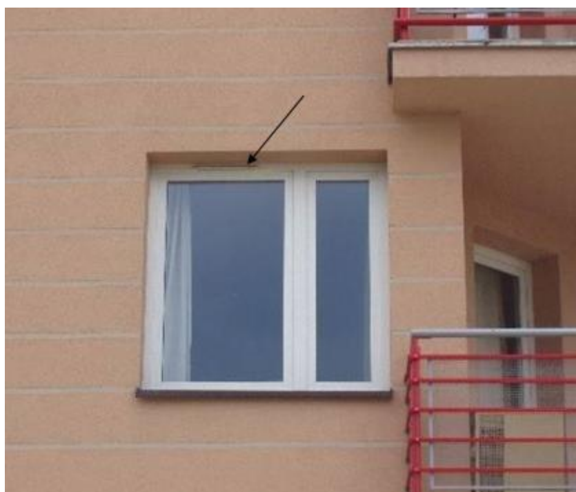
Rysunek 12-14 Okno dźwiękoszczelne z nawiewnikiem
