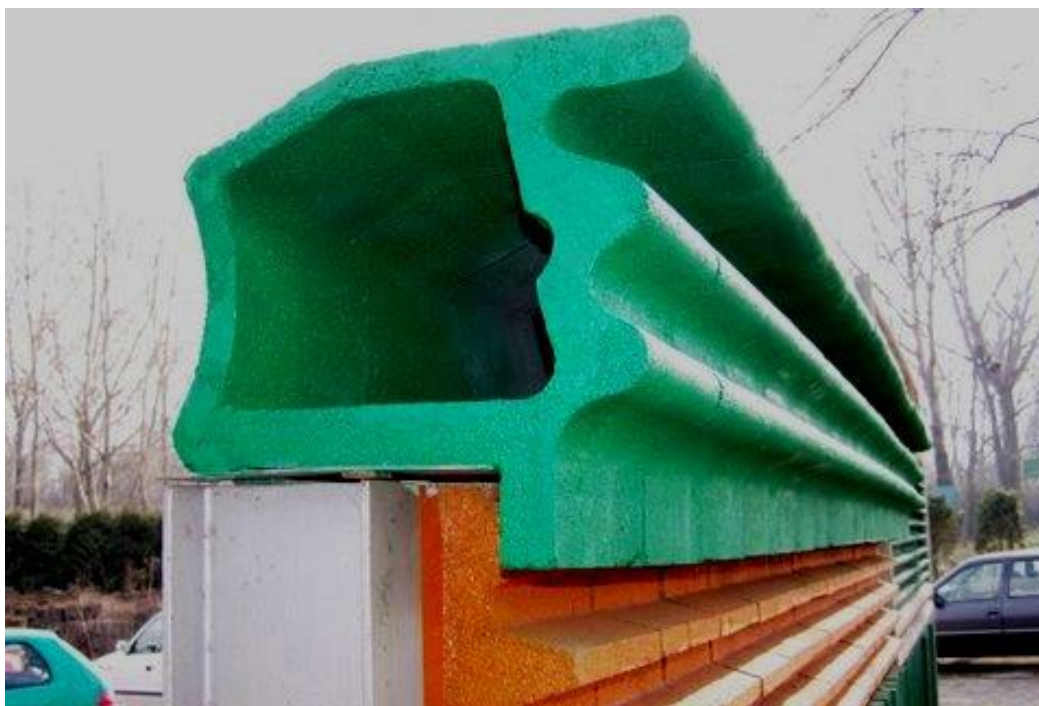
Rysunek 12-8 Dyfraktor zamontowany na krawędzi górnej ekranu akustycznego
