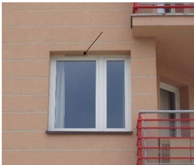
Rysunek 12-15 Okno dźwiękoszczelne z nawiewnikiem
