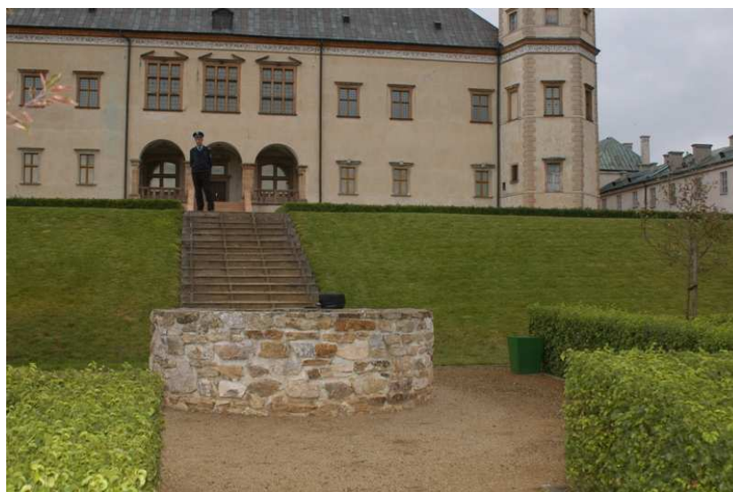
Fot.1. Widok studni z zewnątrz.
