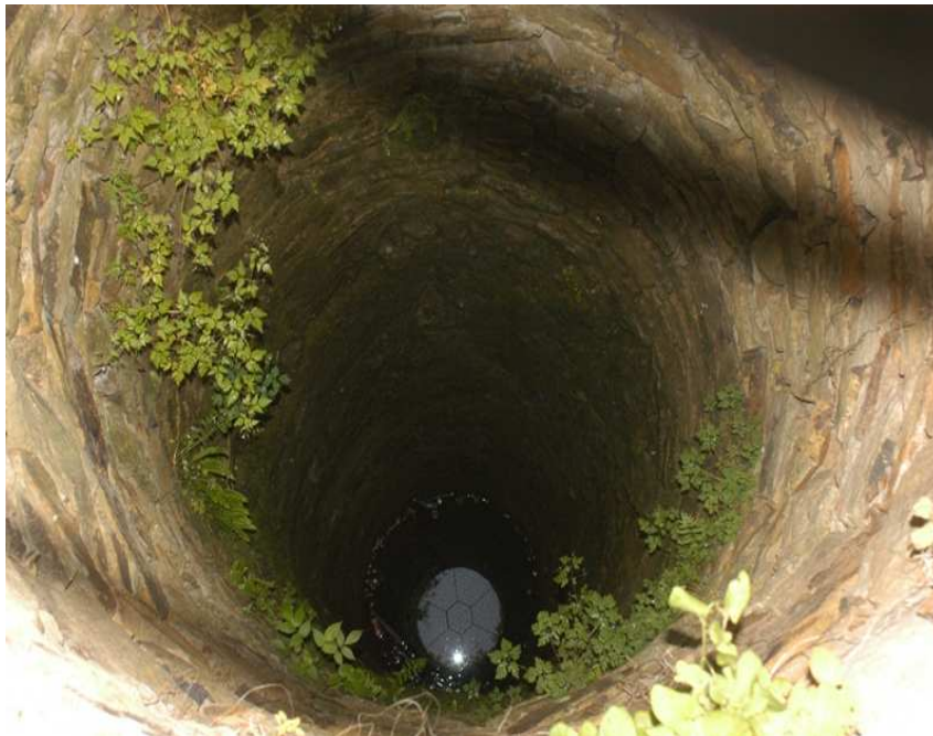
Fot.2. Widok studni wewnątrz przed podjęciem zabiegów regeneracyjnych.
