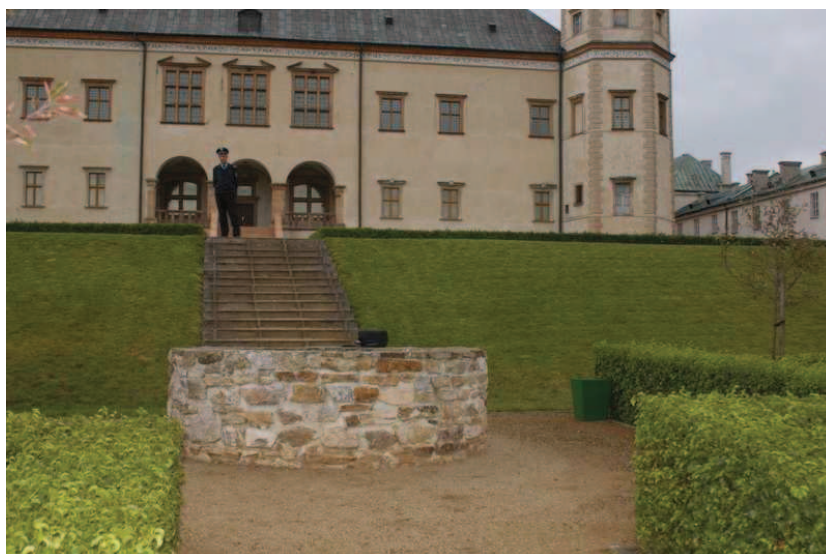
Fot.1. Widok studni z zewnątrz.
