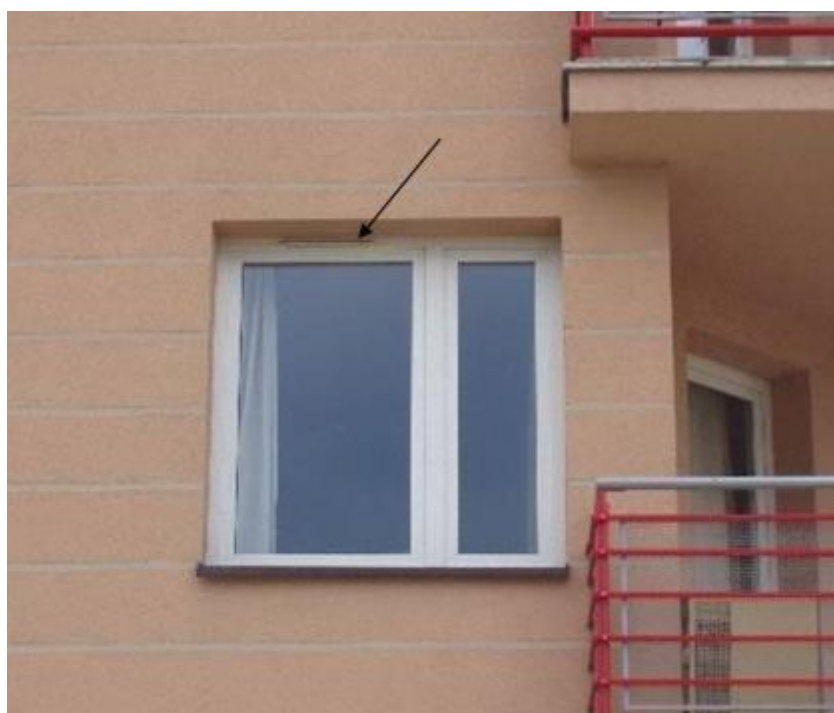
Rysunek 12-14 Okno dźwiękoszczelne z nawiewnikiem
