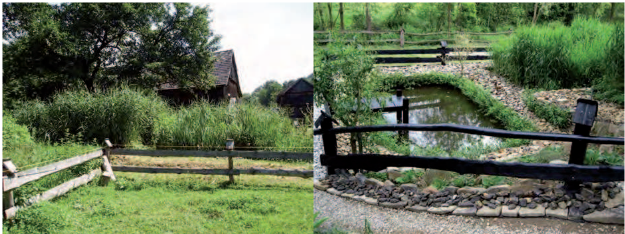
Fot. 8. Widok oczyszczalni ze złożami gruntowo-roślinnymi wykonanej w gospodarstwie agroturystycznym – zamieszkałym do 11 osób
