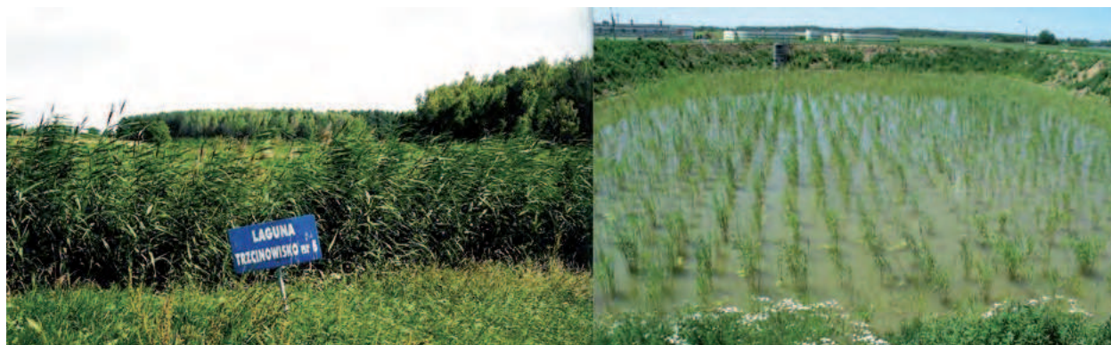
Fot. 12. Przykład hydrofitowego systemu przeróbki osadów ściekowych – oczyszczalnia komunalna w Zambrowie, województwo podlaskie (zdjęcie: Wojciech Dąbrowski)
