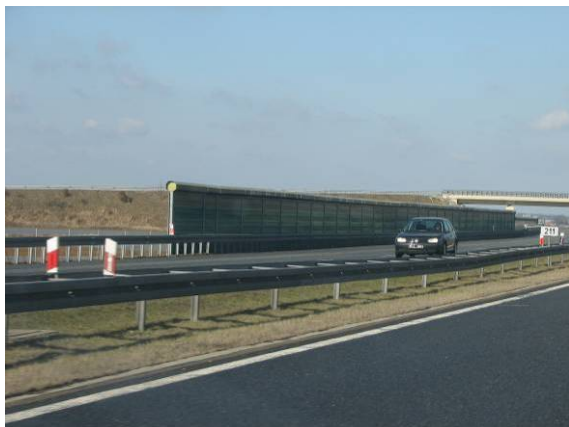
Fot. 7.9. Przykład typowego zastosowania ekranu akustycznego na autostradzie A4 (Polska)
