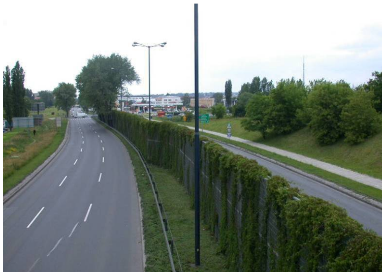
Fot. 7.11. Przykład wału ziemnego (po lewej stronie drogi) oraz ekranu akustycznego w postaci ściany w pasie dzielącym (Polska)
