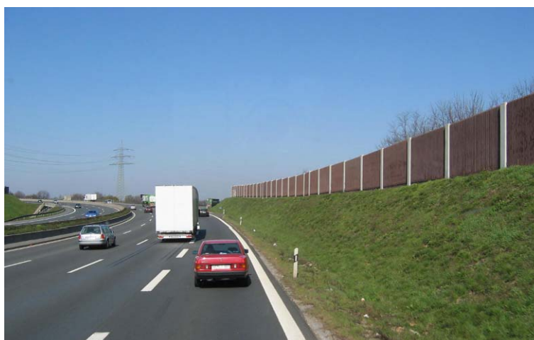
Fot. 7.12. Przykład kombinacji ekranu ziemnego z ekranem akustycznym (Niemcy)
