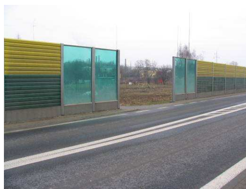
Fot. 7.2. Koniczność zapewnienia zjazdu do posesji – przerwanie ciągłości ekranu akustycznego i słaba jego skuteczność
