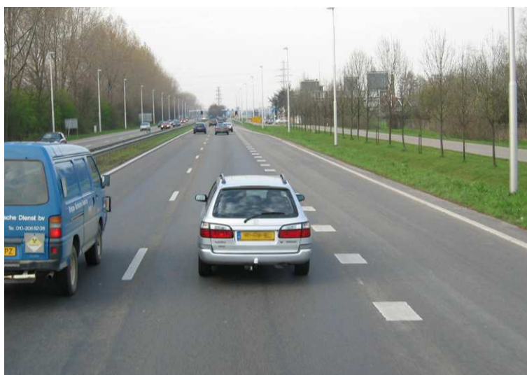
Fot. 7.3. Ukształtowanie otoczenia drogi umożliwiające stosowanie obecnie i w przyszłości różnych form ochrony akustycznej (Holandia)
