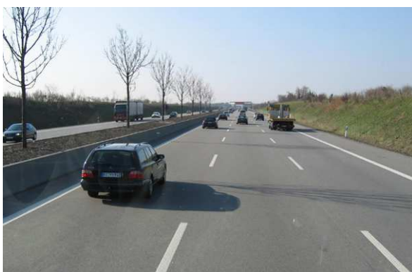
Fot. 7.1. Wykorzystanie ekranujących własności wykopu oraz elementów pasa dzielącego na autostradzie (Niemcy)
