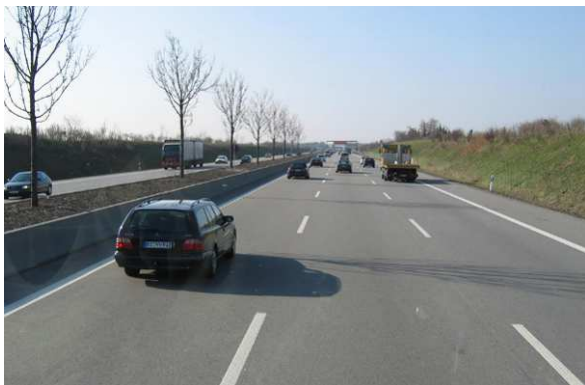
Fot. 7.1. Wykorzystanie ekranujących własności wykopu oraz elementów pasa dzielącego na autostradzie (Niemcy)
