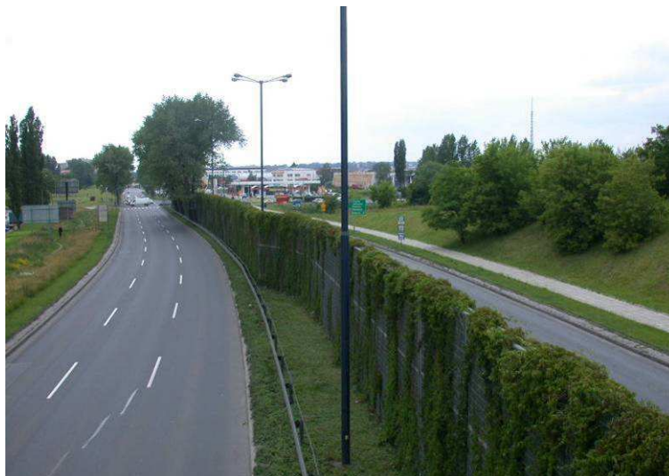
Fot. 7.11. Przykład wału ziemnego (po lewej stronie drogi) oraz ekranu akustycznego w postaci ściany w pasie dzielącym (Polska)
