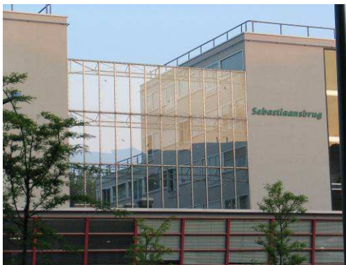
Fot. 7.14. Ekranowanie w postaci domknięcia ścian szczytowych (Holandia)
