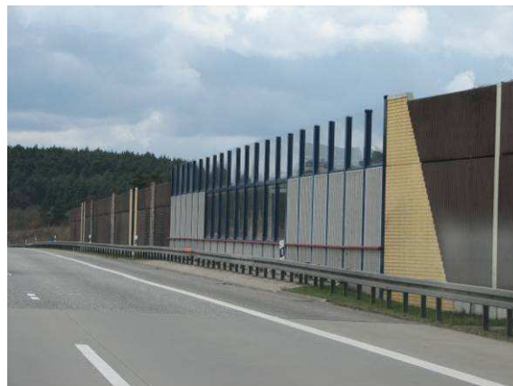
Fot. 7.10. Przykład zastosowania ekranu akustycznego na wiadukcie (Niemcy)
