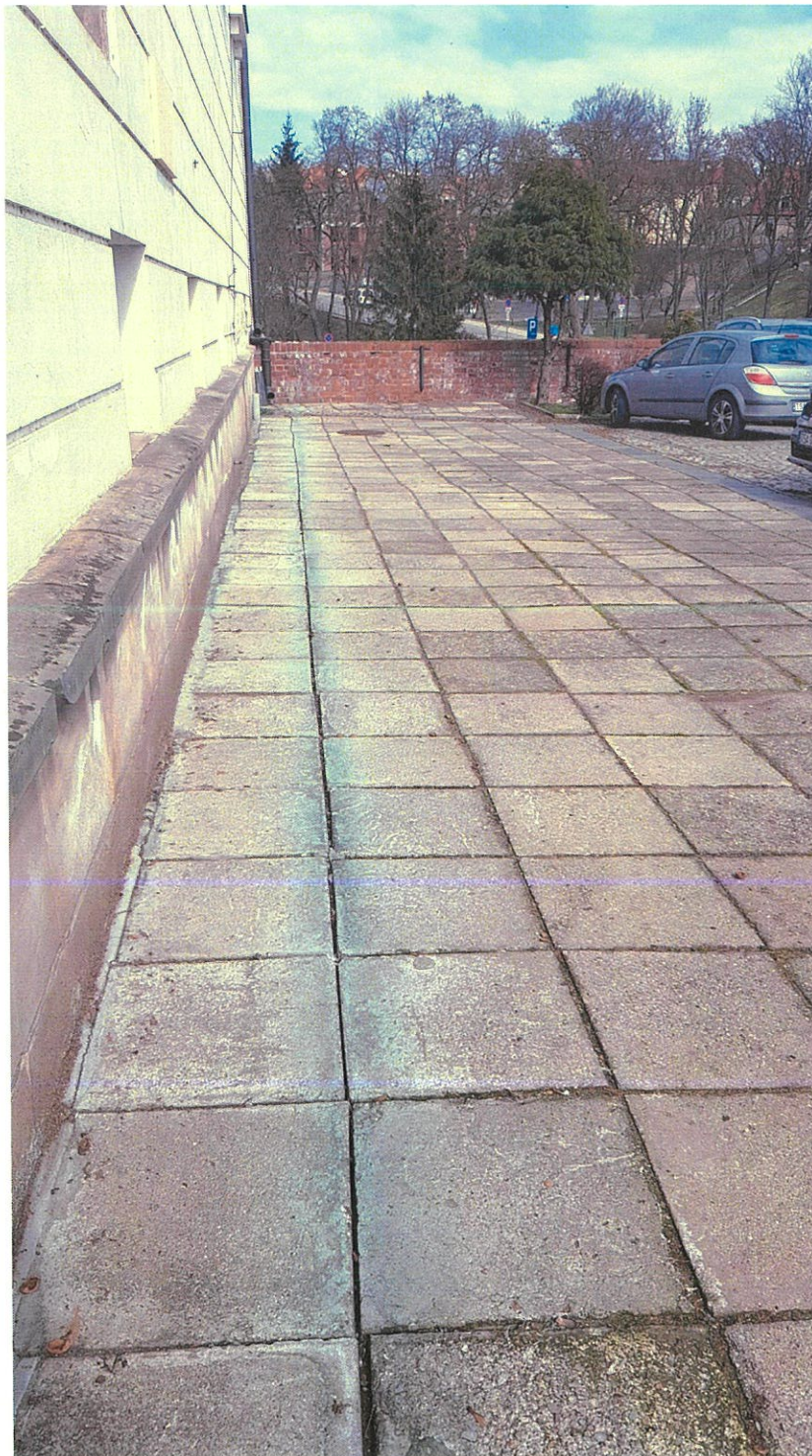
fot. Nr 11 Widok cokołu w elewacji frontowej.
