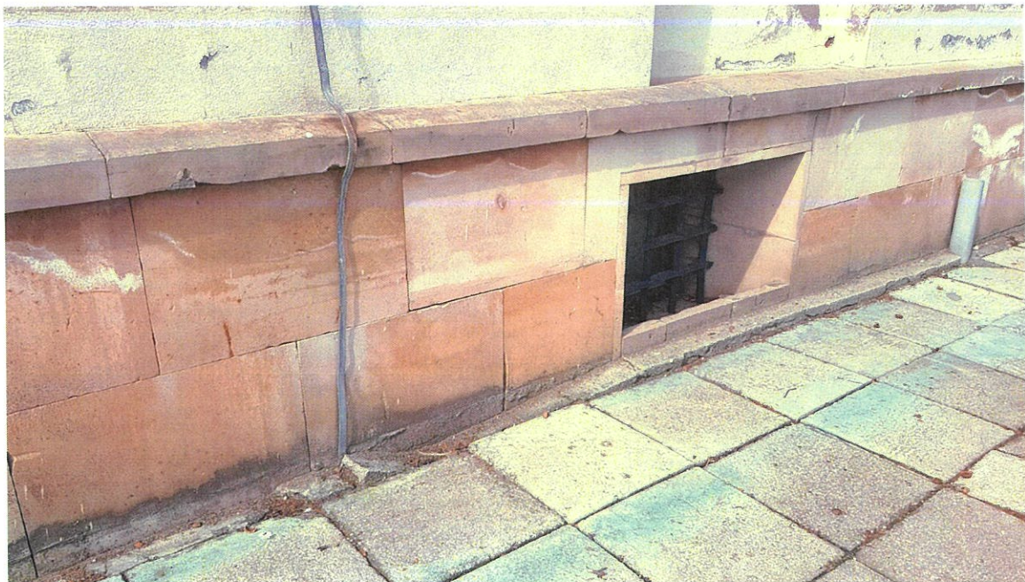
fot. Nr 2 Fragment cokołu kamiennego z piaskowca budynku Zamku- stan zachowania okładziny
