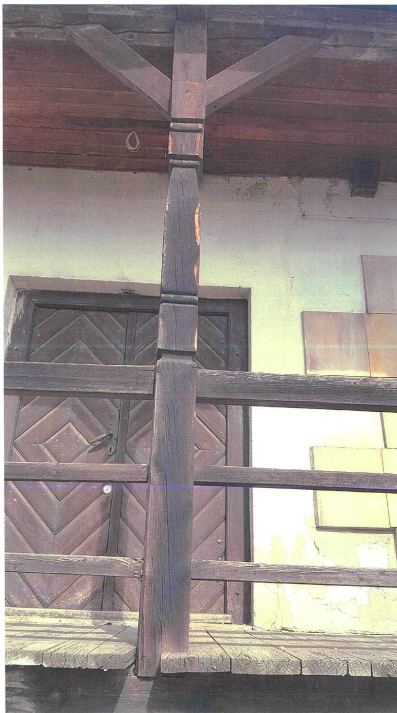
foto. Nr 12 Widok drewnianego zadaszania i podestu baszty od strony południowej.
