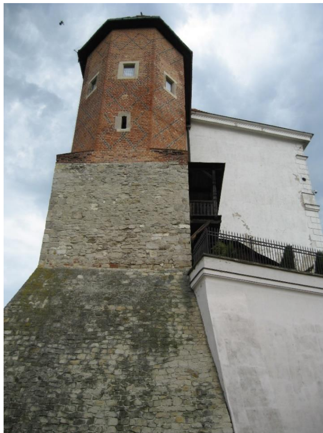
Zdj. 3 Baszta południowa, schody drewniane.
