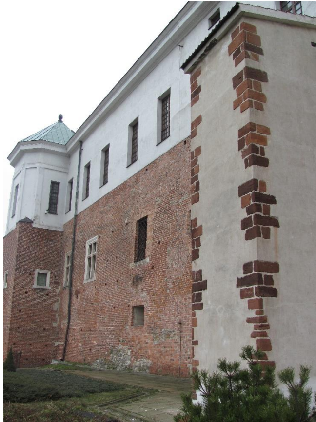
Zdj. 2 Elewacja zachodnia
