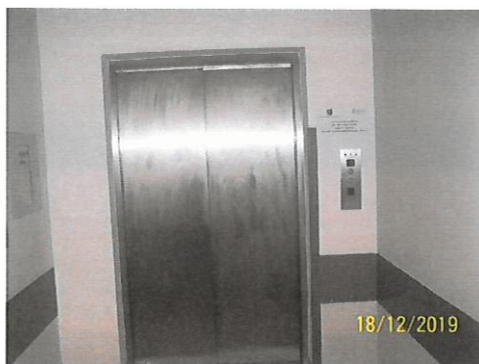
Winda w Samodzielnym Publicznym Zespole Zakładów Opieki Zdrowotnej w Staszowie
