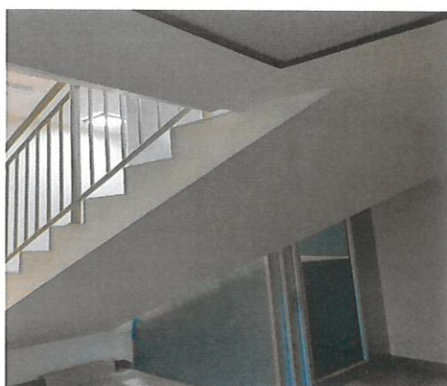
Roboty wykonane w budynku dawnej Szkoły Podstawowej w Gorzkowie
